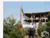
L'abbattimento del mostro di cemento
